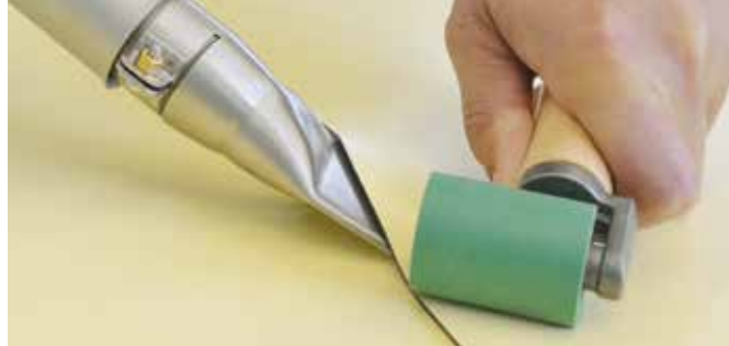
Soldadura a solapa simplificada.
