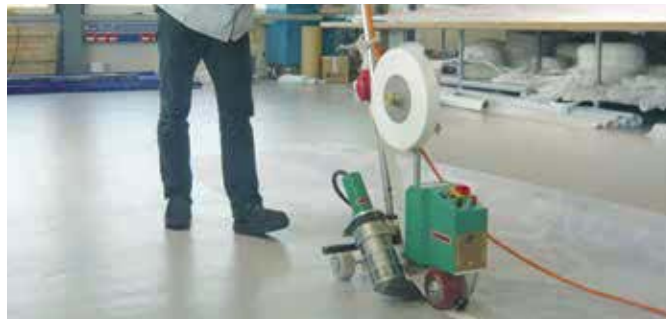
Soldadura de bandas a máxima velocidad.
