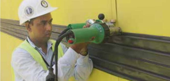
Perfecta para la soldadura de cintas de hermetización de juntas.
